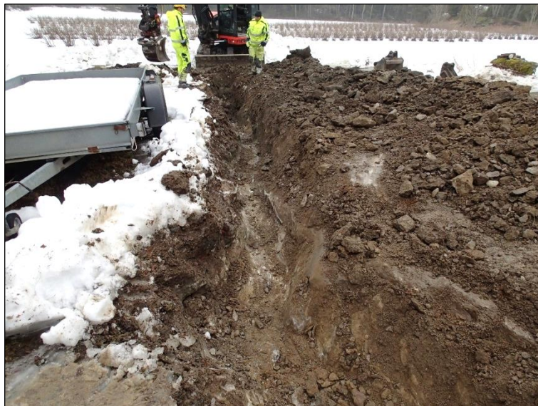
Kuva 7. Kuvaussuunta luoteeseen. Valvotun kaivannon loppupää valmiiksi asti kaivettuna.
