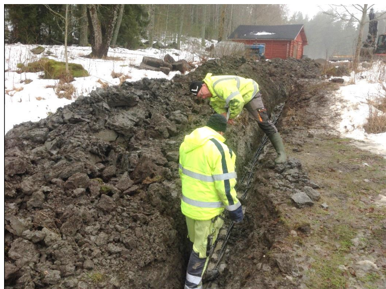
Kuva 18. Kuvaussuunta länteen. Työntekijä (alla) ja maanomistajan edustaja (yllä) tarkastelevat paljastuneita kiviä. Kuvaaja Laura Suvanto.
